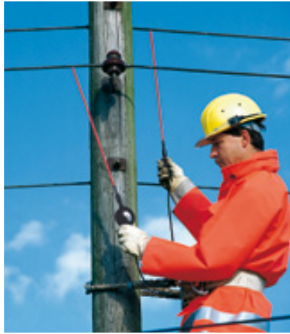
Verlängerungen für höhere Sicherheit an Freileitungen und Stromschienen
