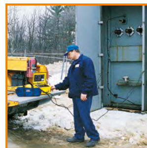
Vor-Ort-Prüfung eines 2000 kVA-Drehstromtransformators
